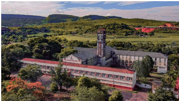
Figura 3. Vista aérea do Hospital Manuel de Abreu.
